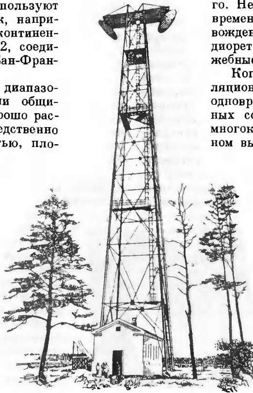
Рис. 3. Антенно-мачтовое устройство промежуточной отечественной радиорелейной станции
