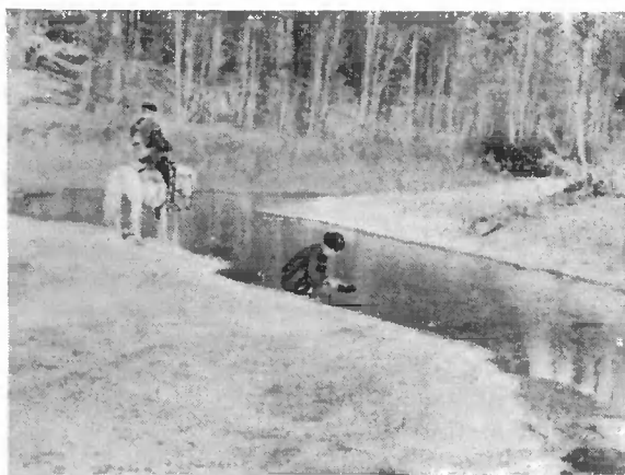
Рис. 7. Ковшечное опробование русловых отложений Тонгуя (приток р. Виллюй)
