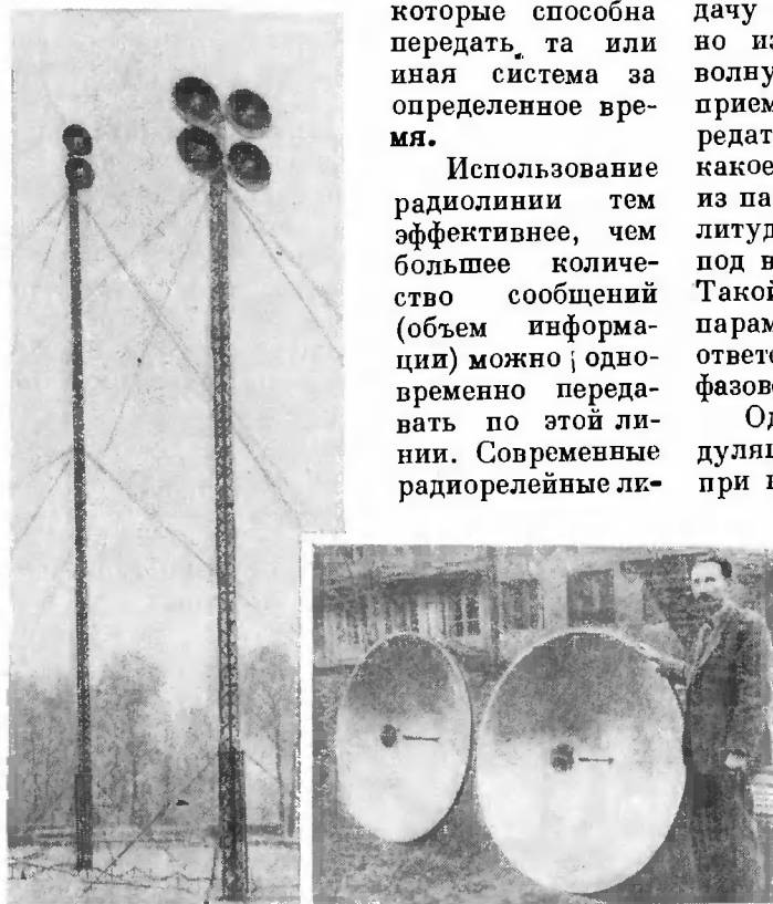
Рис. 2. Антенно-мачтовое устройство оконечных отечественных радиорелейных станций. В правом углу показаны антенны
